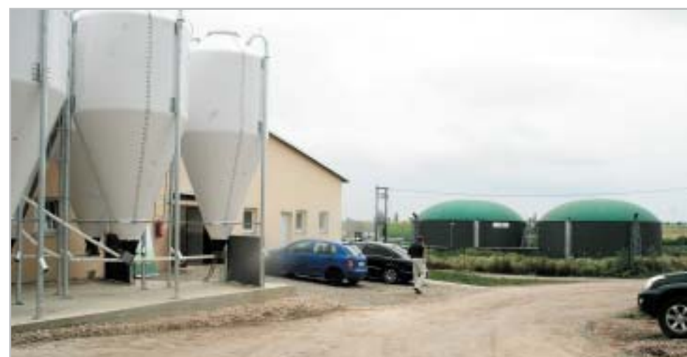
Dokonalé propojení – na chov prasat (kejdové hospodářství) navazuje bioplynová stanice, která produkuje také dostatek tepla pro vytápění
