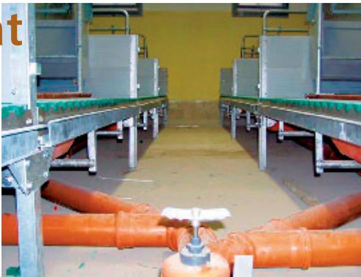
Pohled pod podlahu
