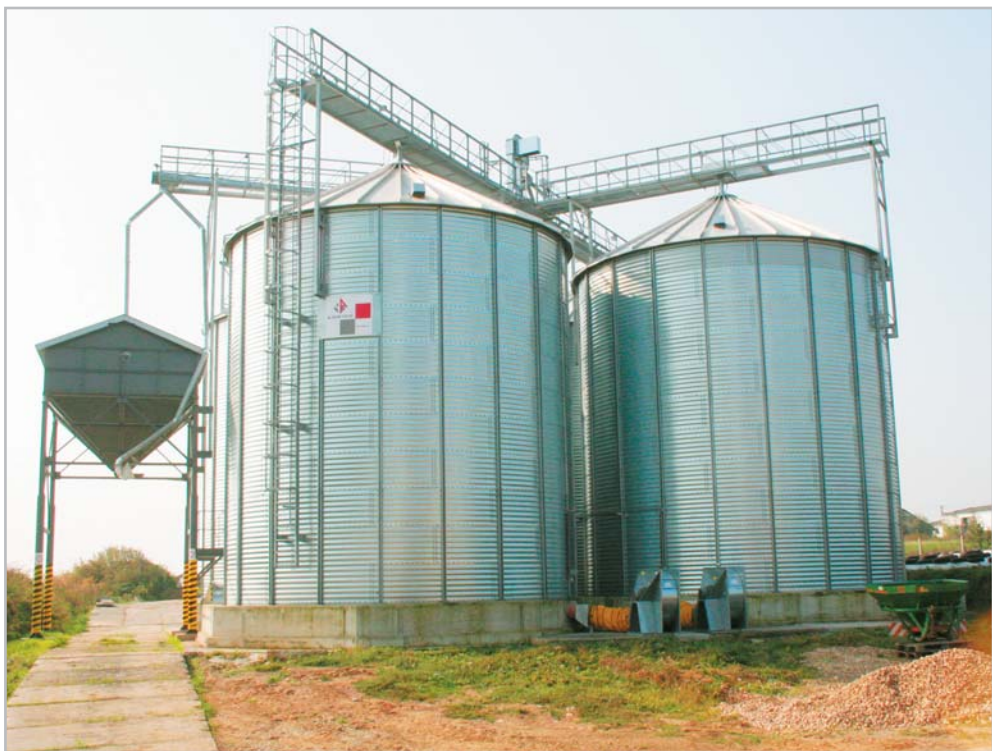
Do čtyř pozinkovaných zásobníků se vejde 1827,2 tuny obilovin, do expedičního zásobníku (vlevo) pak 25 tun
