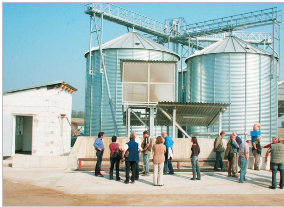
Na snímku vlevo velín, v popředí betonové plato a příjmový koš s výkonem 25 tun za hodinu
