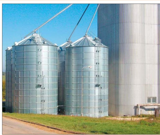
U velkokapacitních sil od třeboňské společnosti Agrico oceňují zemědělci především to, že jde o levné a komplexní stavby, dostatečně povrchově ošetřené, s dlouhou životností. Stejně tak si cení i několika způsobů financování
