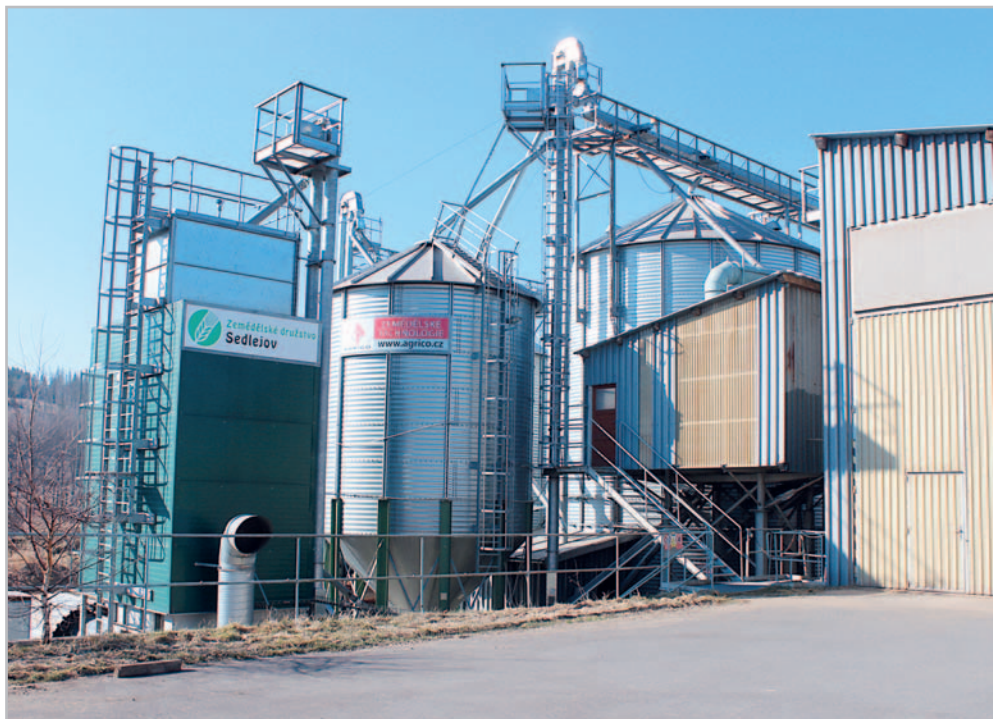
Pohled (zleva) na průchozí sušičku s kumulačním silem pro 120 tun, po schůdkách se jde k čističce Petkus 525 Foto Vladislav Fuka
