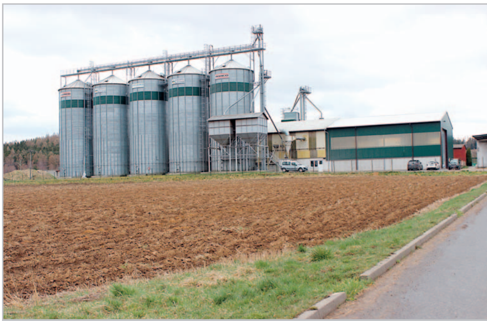
Posklizňová linka v Hudčicích splňuje všechny požadavky investora, navíc je barevně rozlišitelná, takže příliš nenarušuje krajinu Foto Vladislav Fuka
