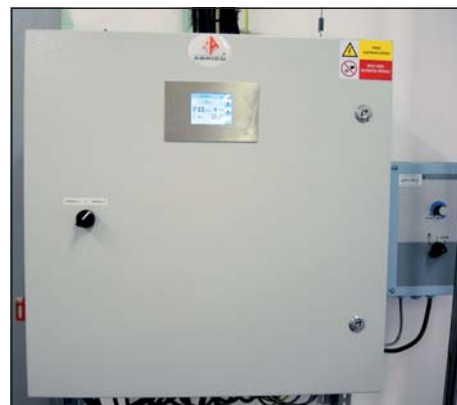
Saját fejlesztésű számítógépes vezérlés. GSM kommunikációval
