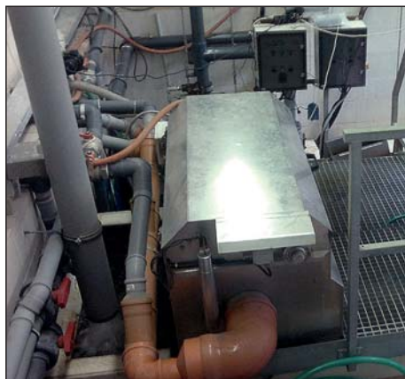
Durva szennyeződések mechanikus szűrése
