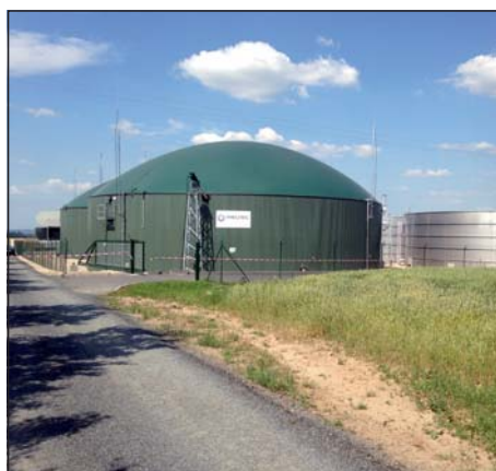
Biogáz állomás - olcsó hőforrás
