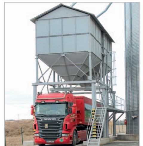
Pod dvěma podjezdovými expedičními zásobníky o objemu 44,9 m 3 je prefabrikovaná mostová váha dlouhá 16 m s váživostí až 60 tun Foto Vladislav Fuka
